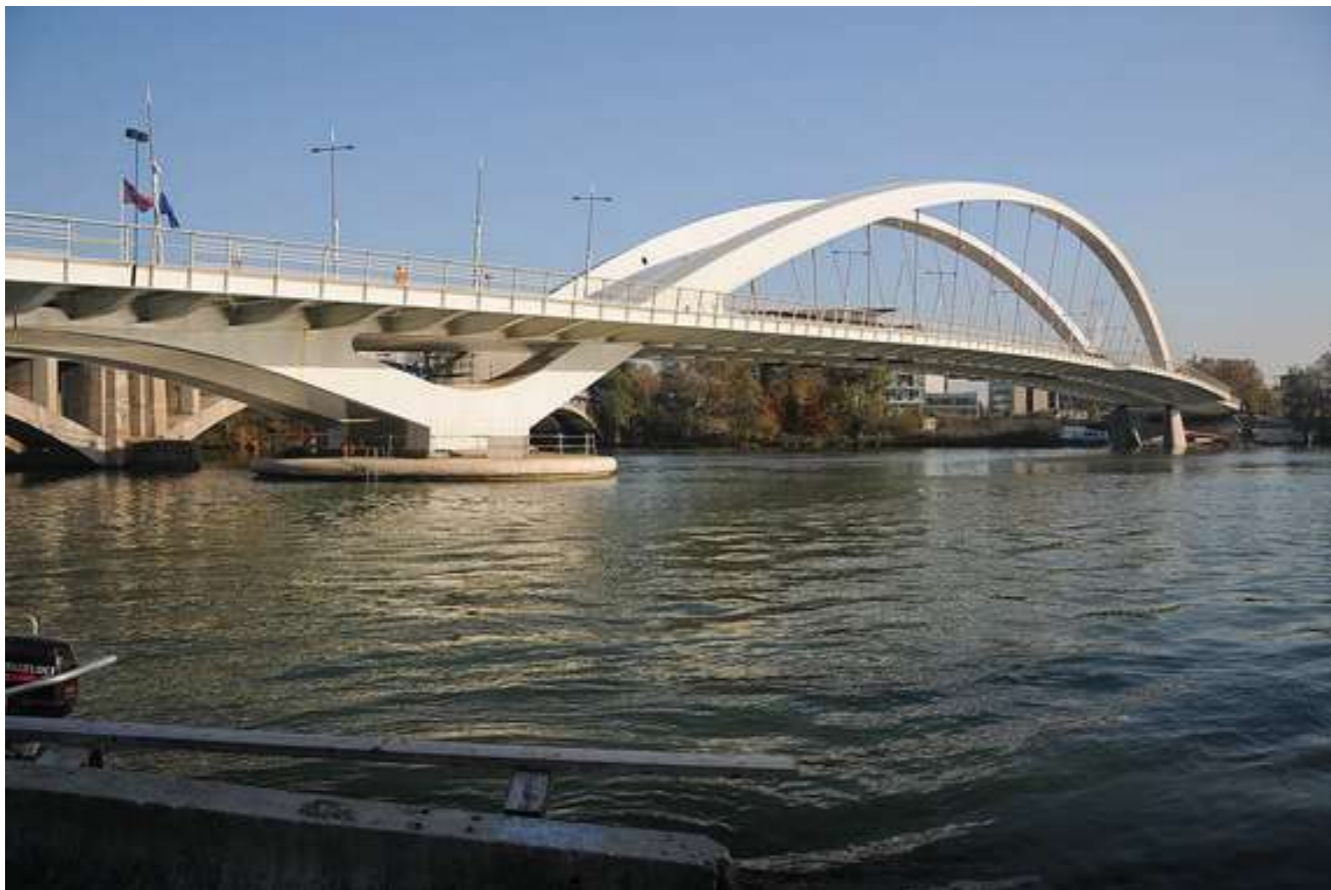
Figure 21 : pont Raymond Barre Lyon
