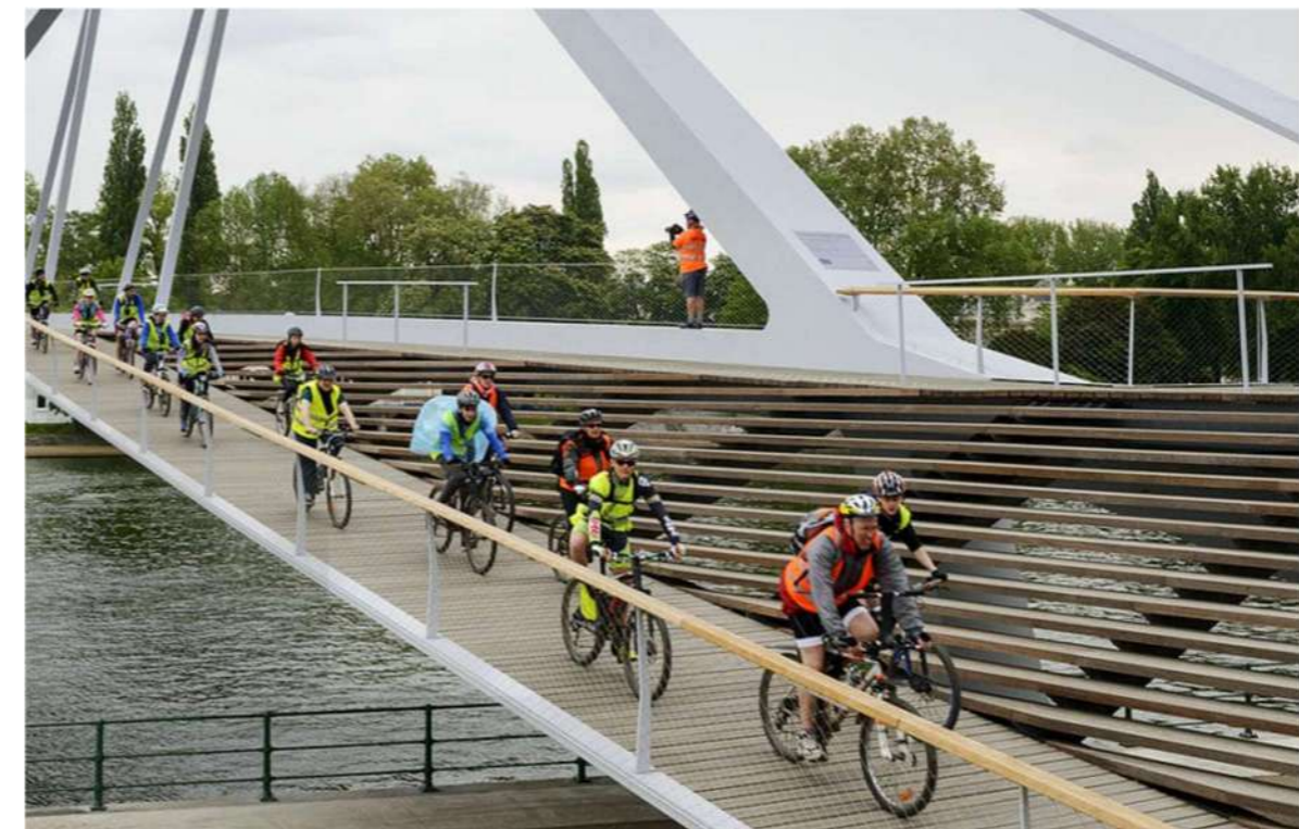
Figure 39 : Passerelle La Belle Liègeoise, Liège, Belgique
