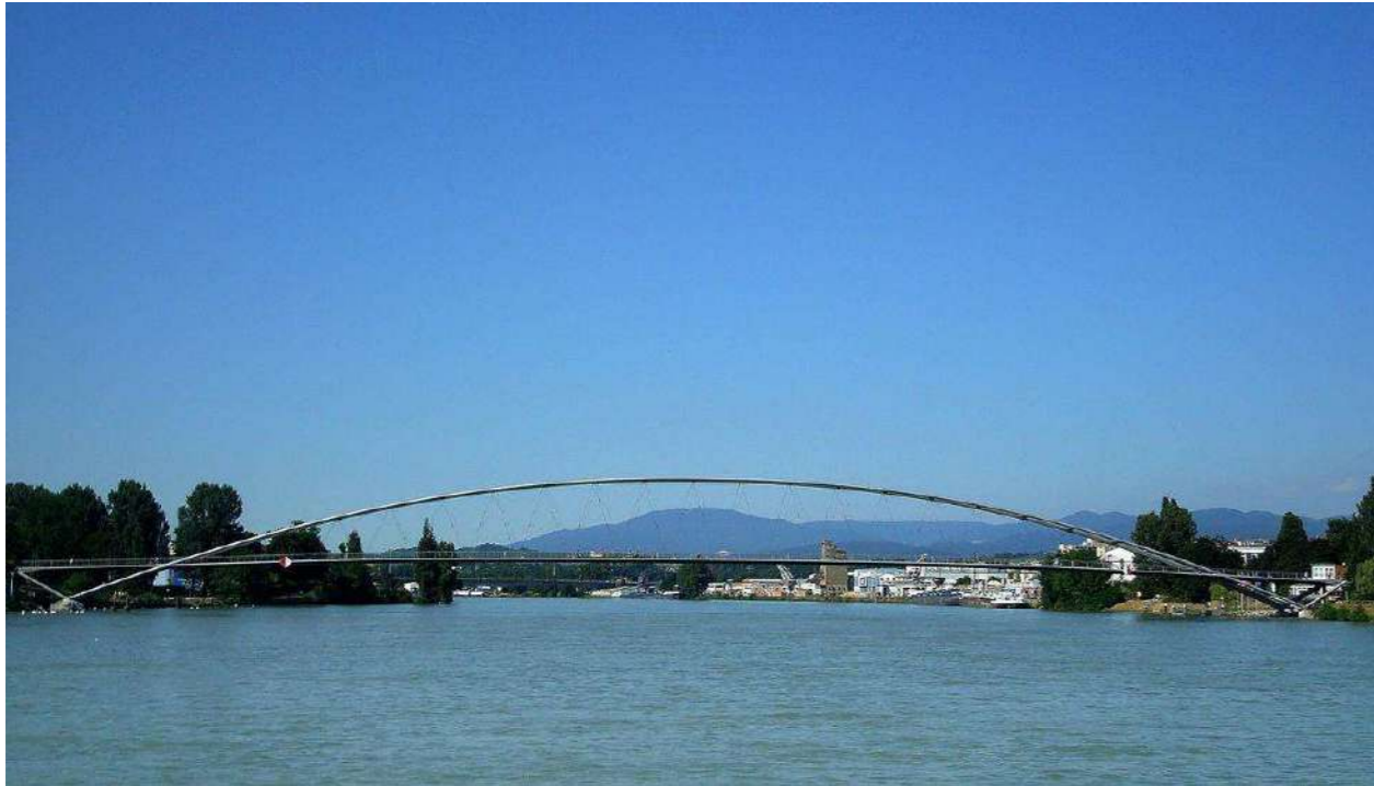
Figure 24 : Passerelle des Trois Pays Allemagne
