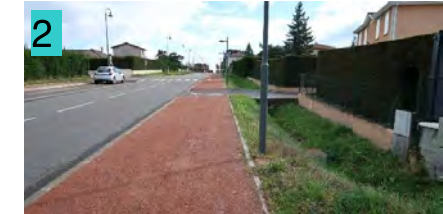
Exemple d'aménagements existants en stabilisé (revêtement non fermé) à changer tout en conservant les principes généraux d'insertion actuels.
