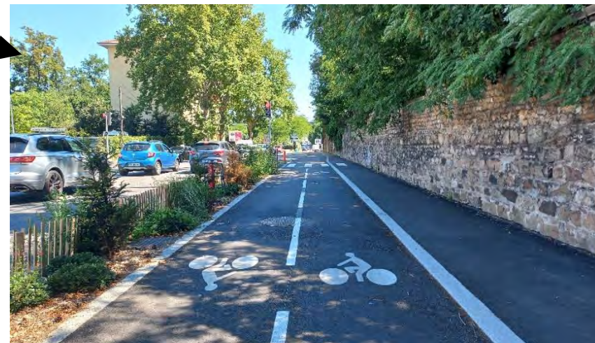
Mise en service récente de la piste cyclable bidirectionnelle sur l'avenue Victor Hugo à Tassin-la-Demi-Lune qui sera empruntée par la Voie lyonnaise numéro 5 et numéro 8
