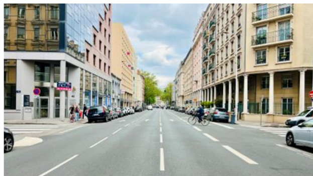
Aménagement existant rue de l'Université (carrefour rue Saint-Jérôme)
