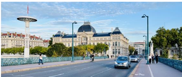
Le Pont de l'Université dans son contexte et aménagement actuels (photos SA)
