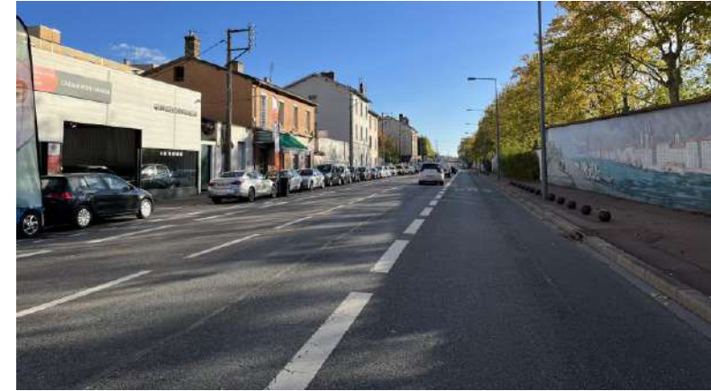
Aménagement existant de la Route de Vienne, Lyon 8 ème / Vénissieux
