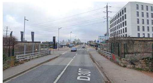
Pont SNCF sud
