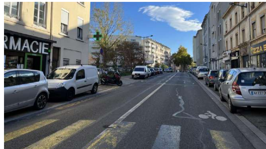
Aménagement existant de la Route de Vienne, Lyon 8 ème
