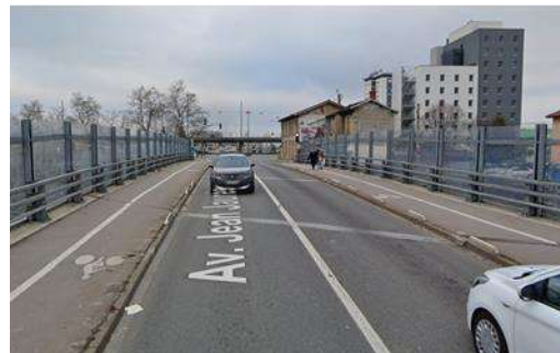
Pont SNCF nord
