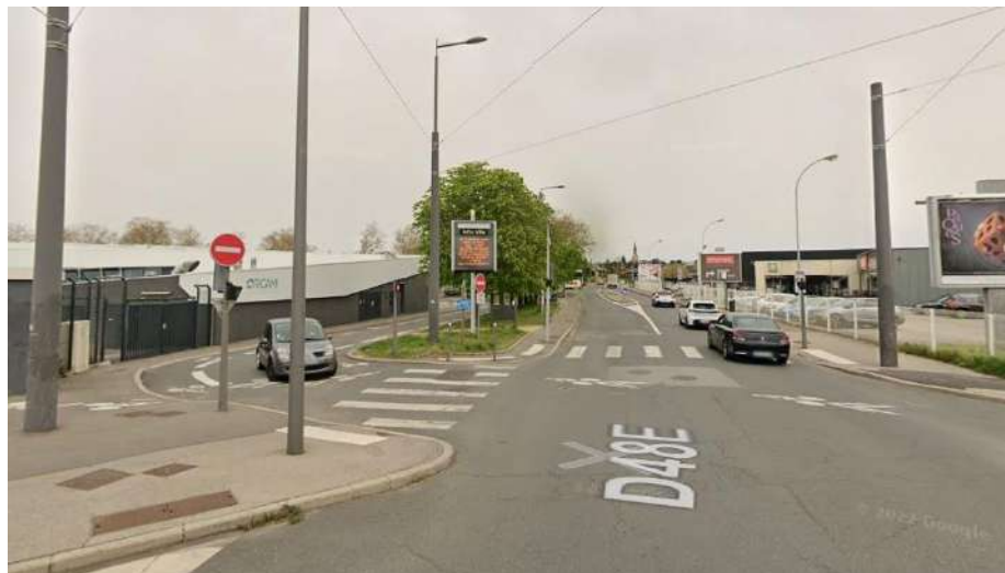
Photos de l'existant : Avenue de l'Hippodrome
