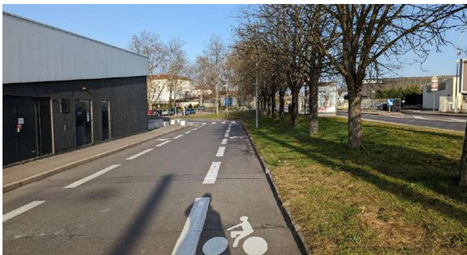
Photos de l'existant : Avenue de l'Hippodrome
