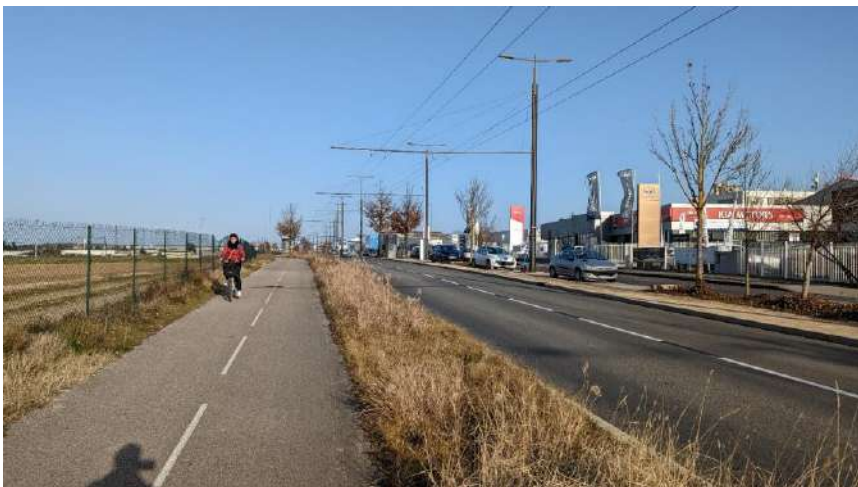
Photos de l'existant : Avenue Général Leclerc
