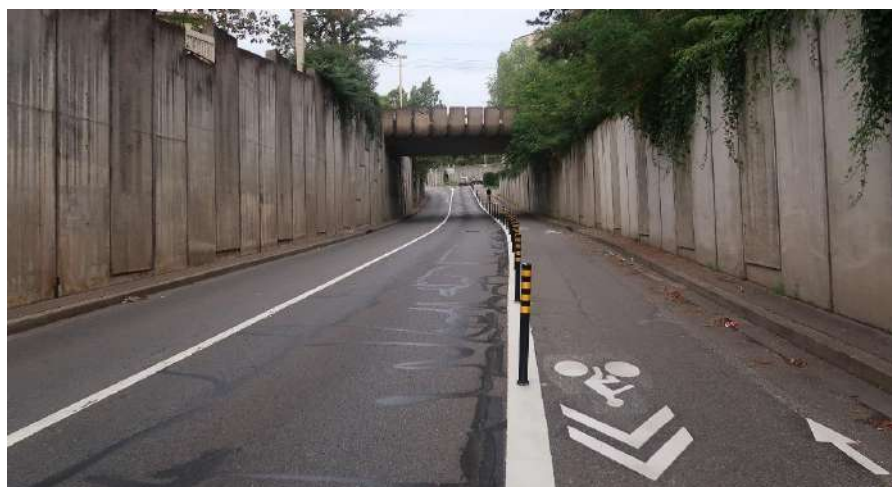
Photo de l'existant : Pont rue des Margnolles
