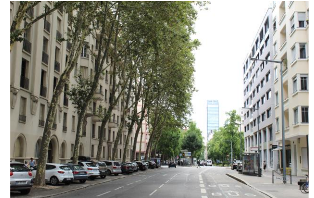
Aménagement existant rue Garibaldi
