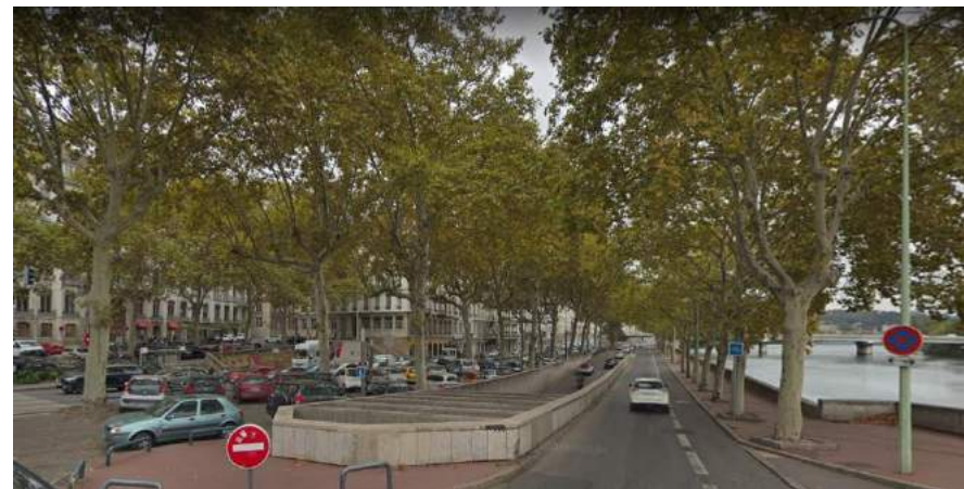
Trémie au droit de la place Pradel
