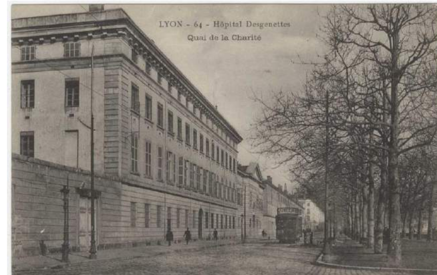
Photos illustrant la présence du tramway sur l'ensemble des quais en rive droite du Rhône
