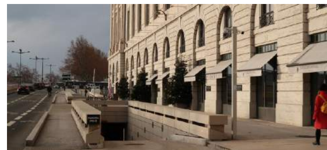
Marches et accès privés souterrains devant l'Hôtel-Dieu
