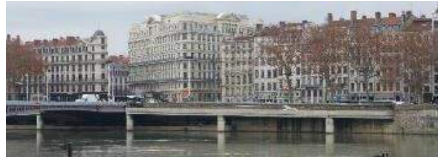
Pont Lafayette avant / après insertion des ouvrages béton.
