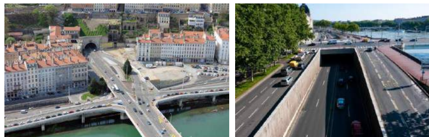
Trémie et tunnel de la Croix Rousse
