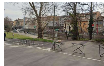
Rampe existante depuis la rue E. Herriot
