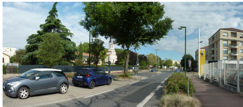
Aménagement existant (Boulevard de l'Europe)
