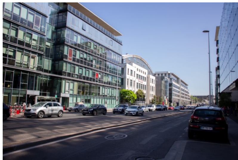
Aménagement existant boulevard Vivier Merle
