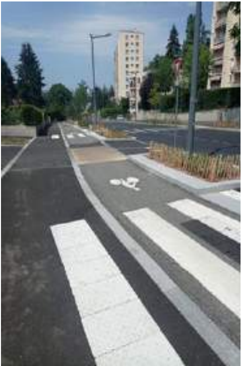
Photos aménagements cycles et piétons
