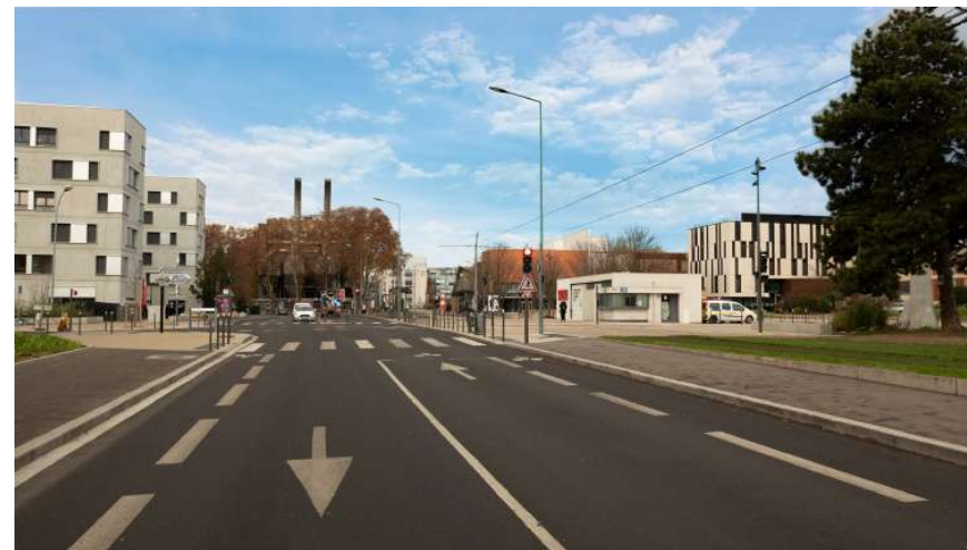
Aménagement existant de l'Avenue Einstein
